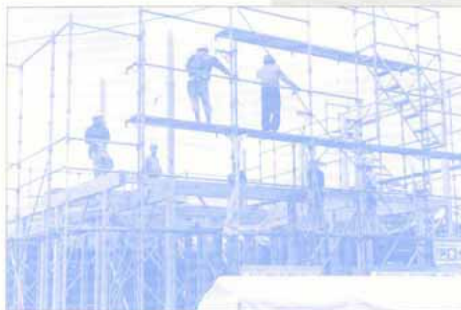
■ 足場上での建方作業の例 ■
