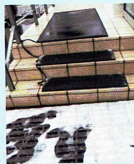
《ヒートマットの設置例》
