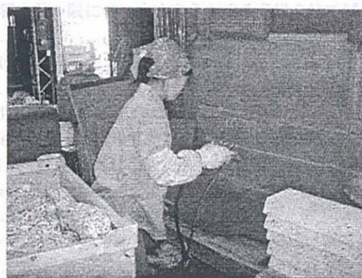
接着剤の吹き付け作業
