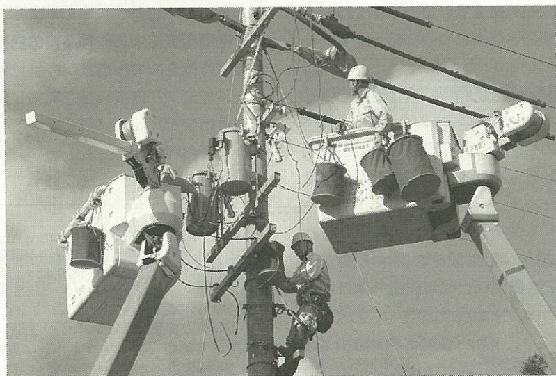
写真1 配電工事の様子
